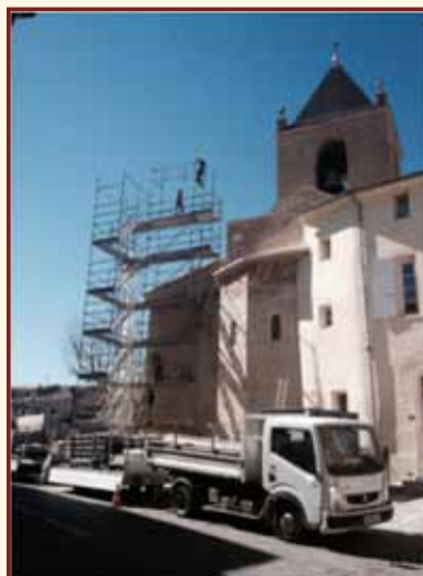
Démontage de l'échafaudage
