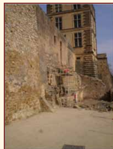
Mur de soutènement de la place du Château
