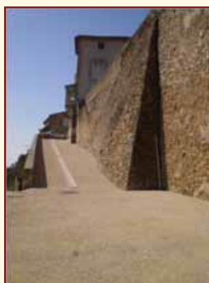
Rénovation de la Rue sous le Château
