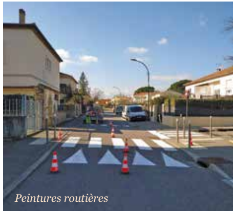
Chemin de Verdache
