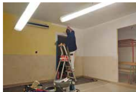
Rénovation du vestiaire des équipes féminines
