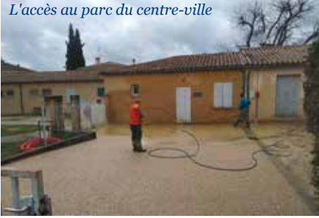
L'accès au parc du centre-ville
