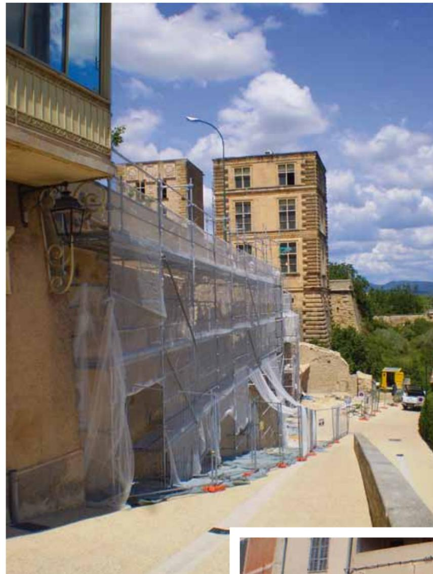
Travaux sur le patrimoine aussi avec l'achèvement de l'opération de confortement et de réfection des enduits du mur de soutènement de la place et des douves du Château, la restauration partielle du mur de soutènement des écoles, vestige de l'ancienne terrasse septentrionale des jardins du Château ou la mise en valeur du porche médiéval de l'entrée Sud du Village avec la réhabilitation de la partie haute de la rue du Pont de l'Èze.
